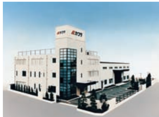
設計、サービス拠点（東京工場）
