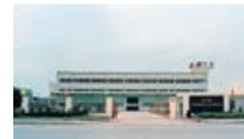
川田機械製造(上海)有限公司
