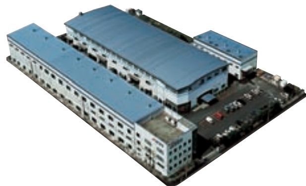
設計、開発、生産拠点 (三田工場)
