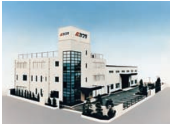
設計、サービス拠点 (東京工場)
