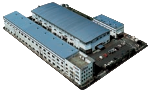
設計、開発、生産拠点（三田工場）
