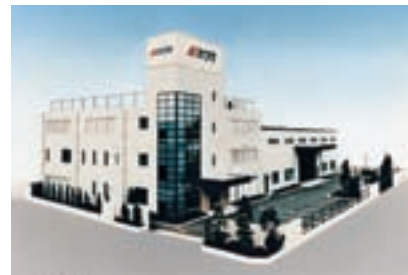
設計、サービス拠点 (東京工場)
